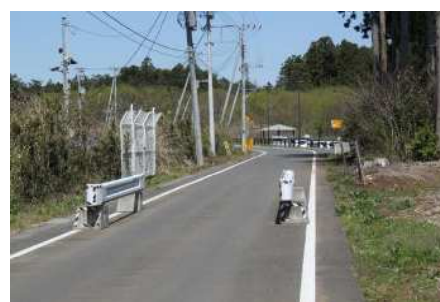
道路の狭あい化措置
