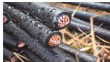
切断された銅線ケーブル
