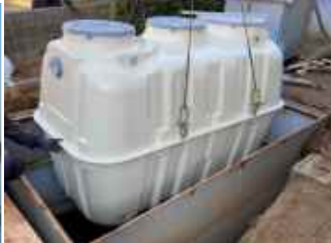
高度処理型浄化槽の設置
