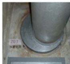
貫通部の止水処置(例)
