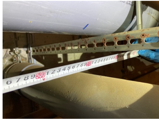
【写真4 振れ止め支持】
