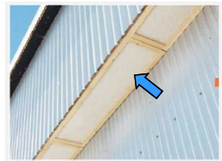
鶏舎入気口フィルターの例 (粉じん、羽毛等の取込み対策にフィルター等を設置)
