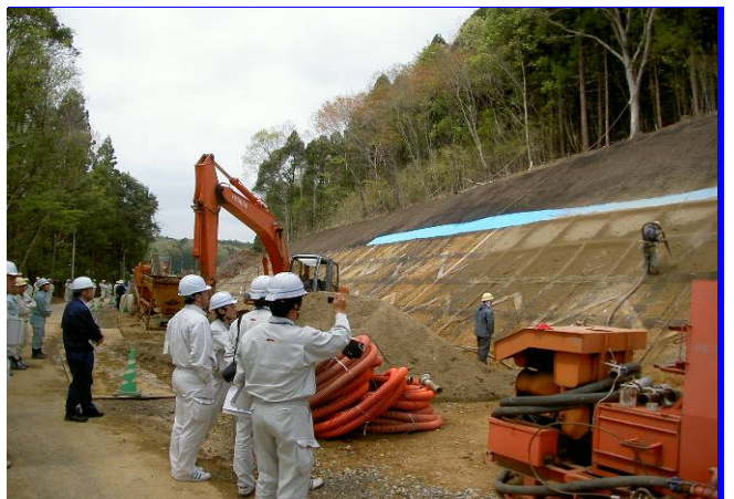
茨城県 現場研修会実施状況
