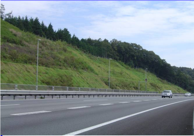
三重県 亀山東ジャンクション工事
