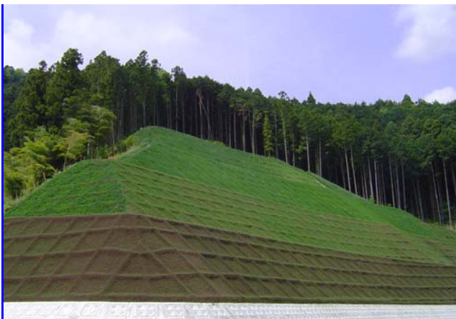
静岡県 清水IC北道路建設工事
