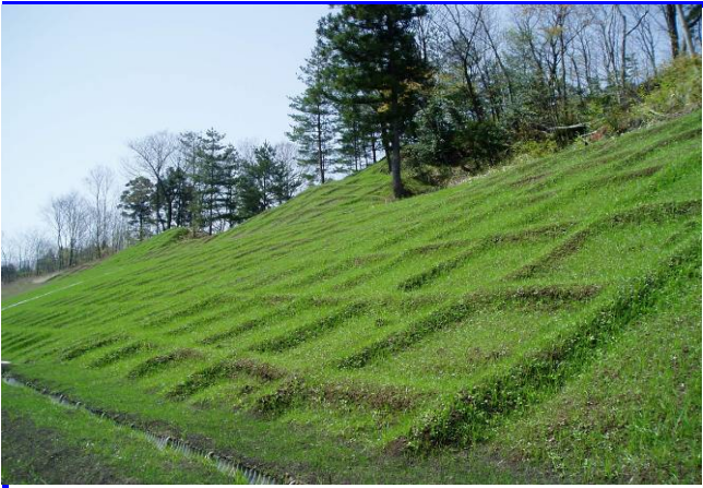
新潟県 後谷ダム二期建設工事
