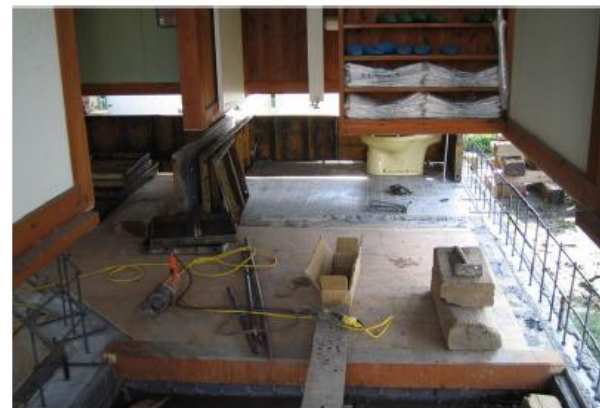
ジャッキアップ後の配筋施工状況【7/31(日)】
