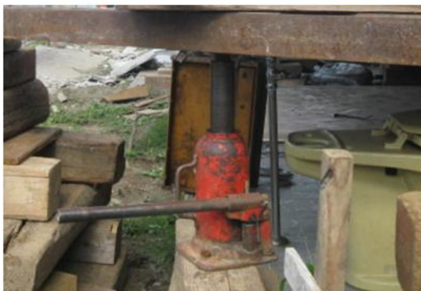
ジャッキアップ施工状況【7/30(土)】
