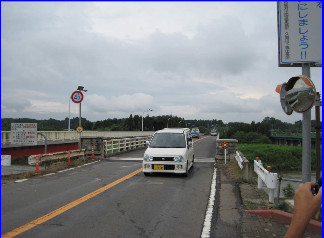
通行止め解除状況写真
