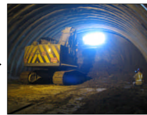
平成22年9月9日 祝 トンネル貫通
