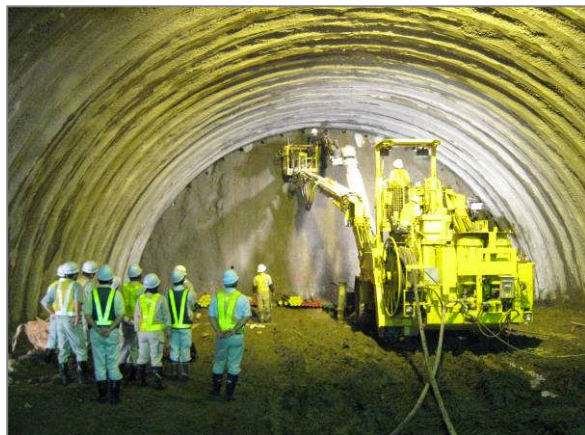
(仮称)常陸太田トンネルの掘削状況
