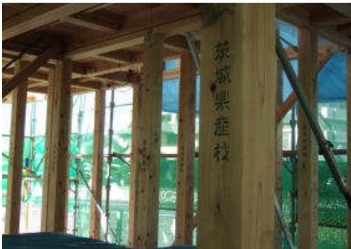
県産材を使用した新築住宅（建築中）
