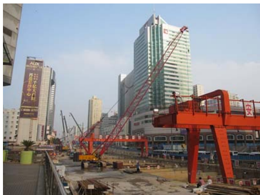
市内中心部では地下鉄工事が進行中
