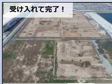
建設発生土の搬入と搬出!
