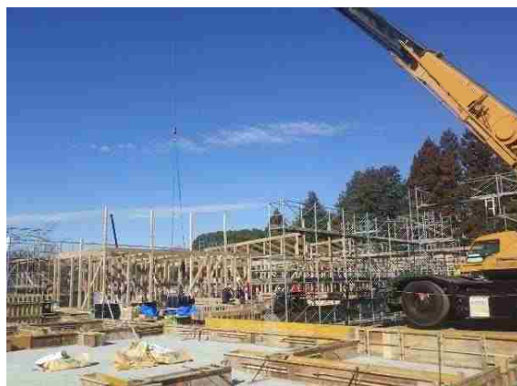
現在施工中の工事現場
