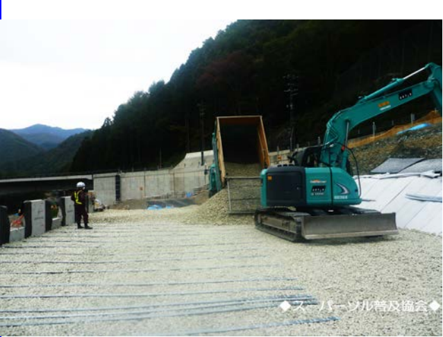
投入・敷均し【テールアルメ裏込め】
