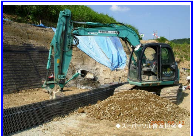
軽量混合土・発生土と混合【テプサー裏込め】
