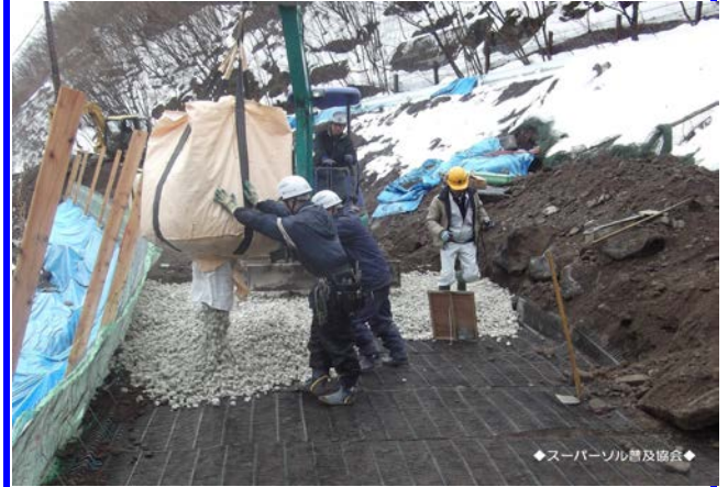
投入【(ジオグリッド裏込め)】
