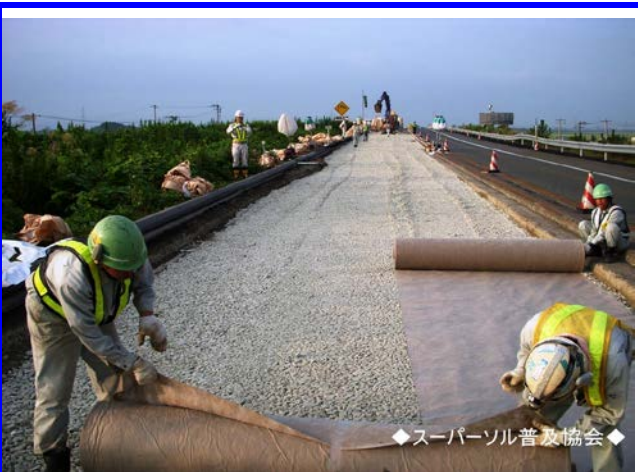
土木透水シート敷設【高速道路の段差修正】
