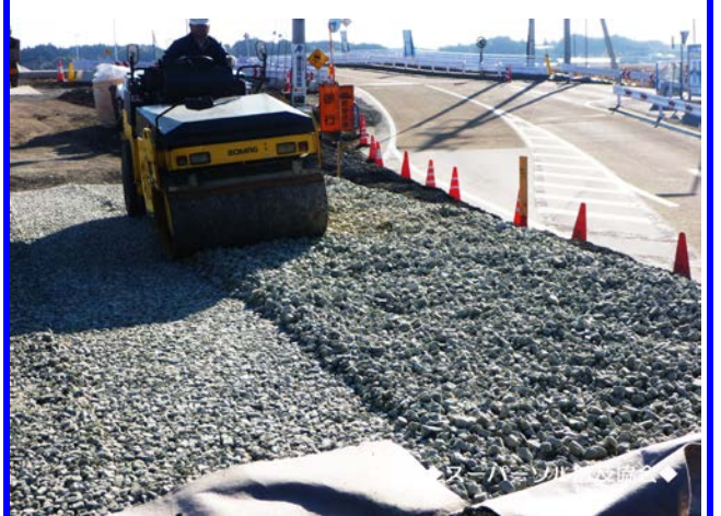
転圧【軟弱地盤上の路床軽量化】
