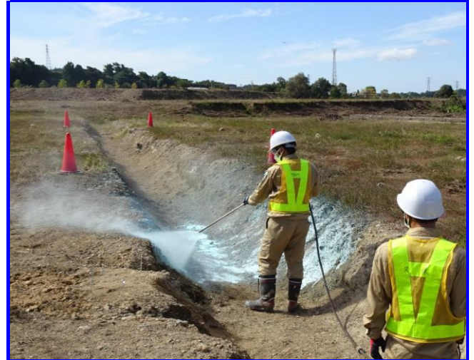
処分場内雨水側溝に施工
