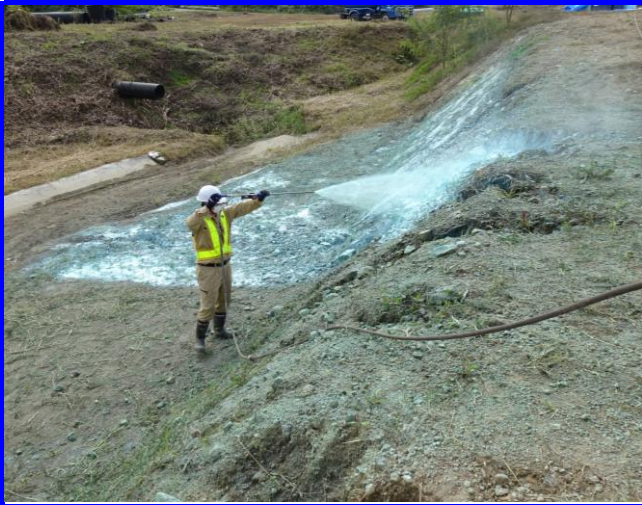
処分場内法面に施工
