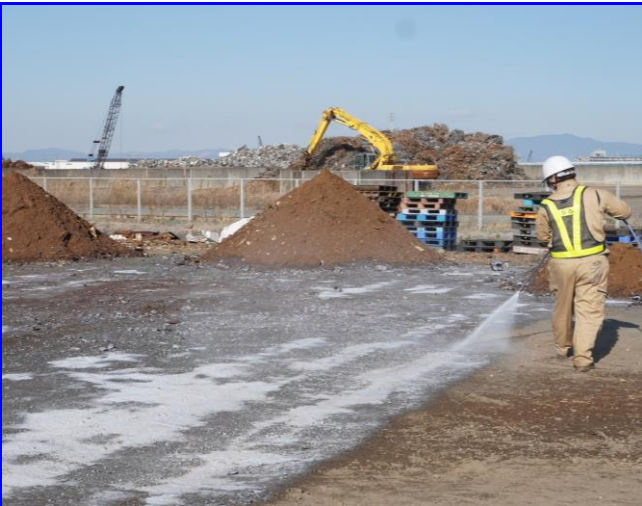
作業現場内平面に施工
