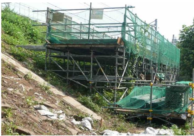
鉄道盛土耐震補強工事
