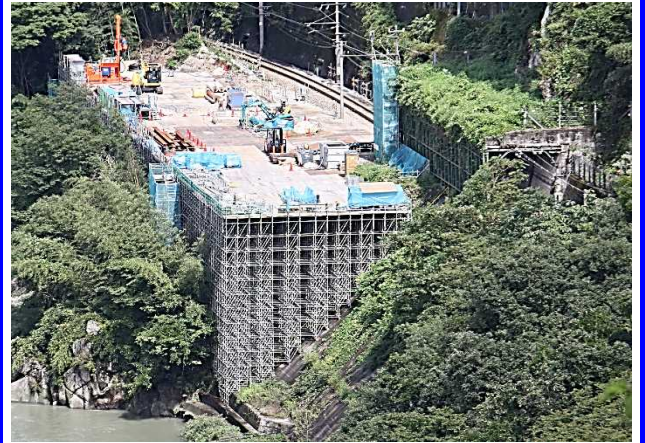
鉄道防護工新設工事
