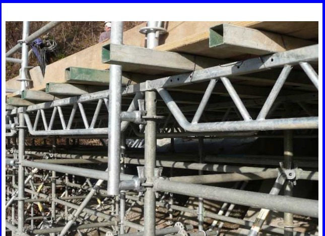
システム化された構台部
