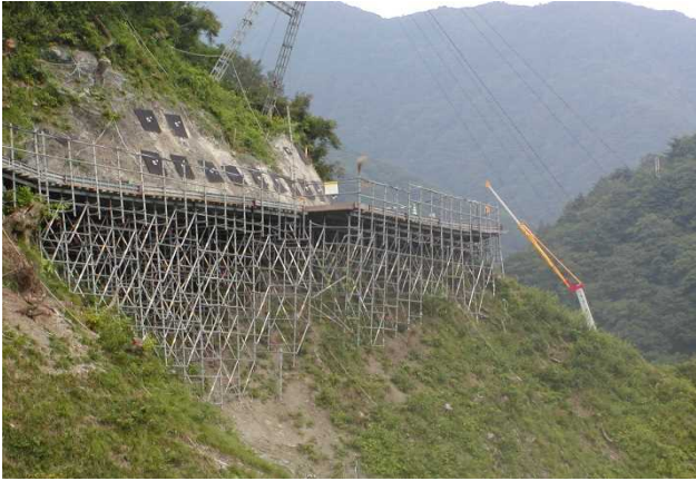
災害復旧工事
