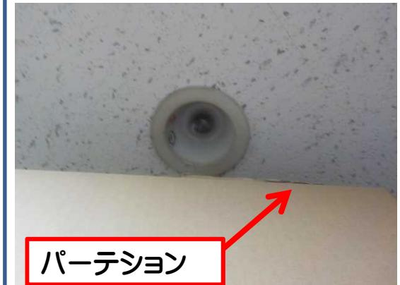
建築された後、非常用の照明装置の下にパーテーションが設置されている例
