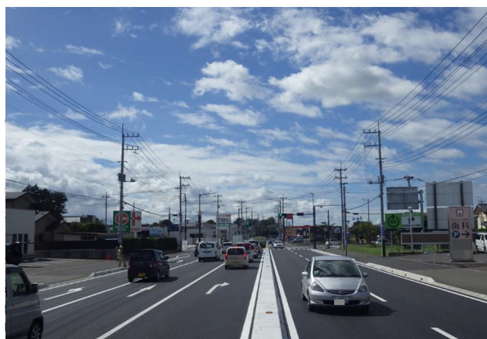
4車線整備完了後の状況(米沢町東交差点付近)
