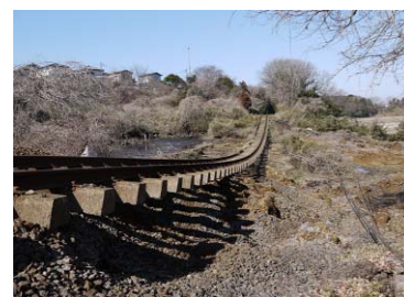
鉄道路盤の流出 (ひたちなか海浜鉄道湊線)
