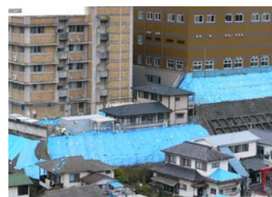
急傾斜地崩壊防止施設の破損 (水戸市)
