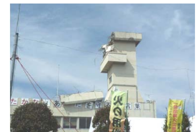
消防施設の被害 (常陸大宮市)
