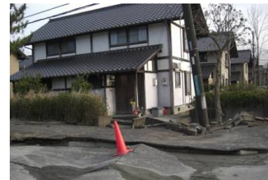
県営日の出住宅の不同沈下 (潮来市)
