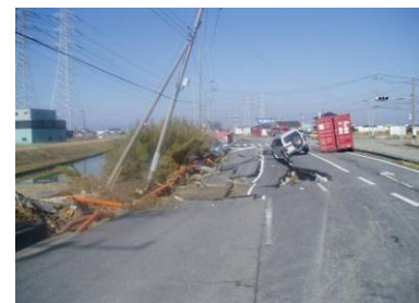
路面の隆起・沈下 (神栖市)
