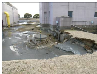
鰐川浄水場の液状化 (鹿嶋市)
