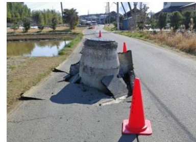
マンホールの隆起 (鹿嶋市)
