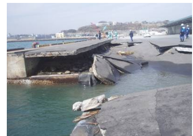
埠頭用地の破損・流出 (茨城港日立港区)
