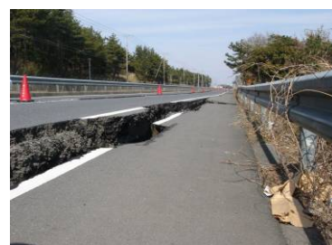
一般国道51号の亀裂・沈下 (大洗町)
