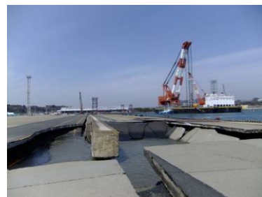
埠頭用地の破損・流出 (茨城港日立港区)
