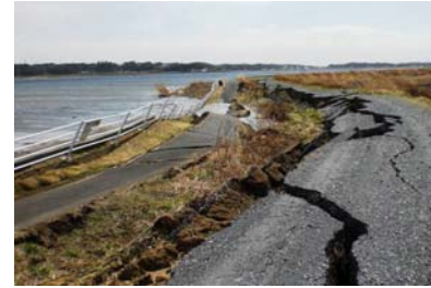
涸沼の堤防・護岸の崩壊 (茨城町)
