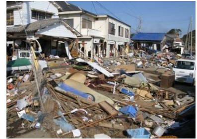
建物の破損・流出 (北茨城市)
