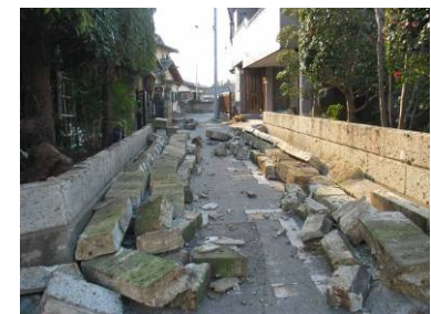
ブロック塀の倒壊 (笠間市)
