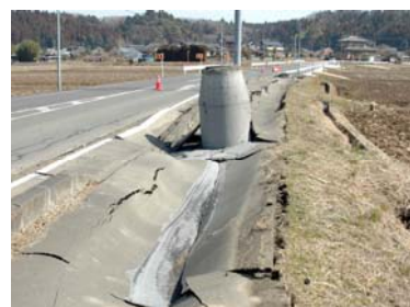
下水道マンホールの隆起 (常陸太田市)
