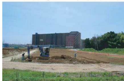
③ 地区北側の宅地整形工事の様子 1月頃に使用収益開始予定です
