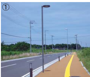
LED照明(島名環状線)
