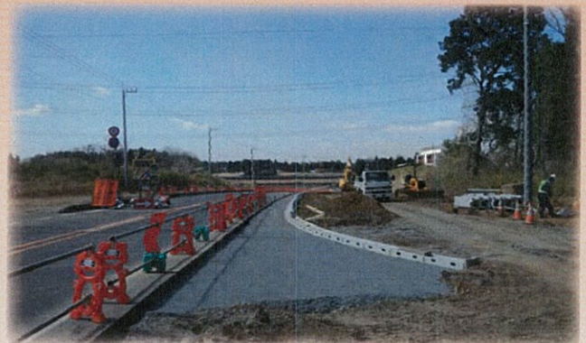
土浦坂東線バイパスの道路工事の様子
