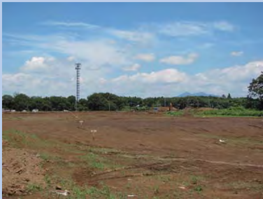
②つくば真岡線バイパス東側の造成工事の様子
