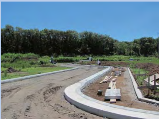
③島名上河原崎線北側の区画道路工事の様子
