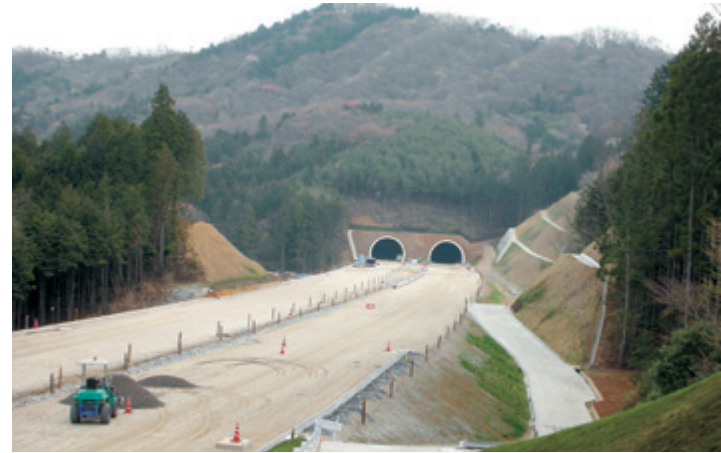
整備が進む北関東自動車道(建設中の唐桶山トンネル付近)
