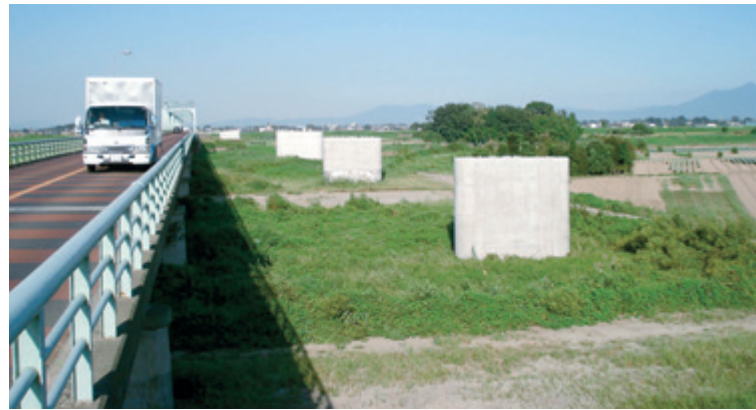
筑西幹線道路の一部として建設が進められる県道筑西三和線(仮称) 鬼怒川新橋
