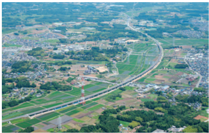
整備が進む圏央道(境ICから猿島岩井IC区間)はこの秋に用地測量が予定されている
