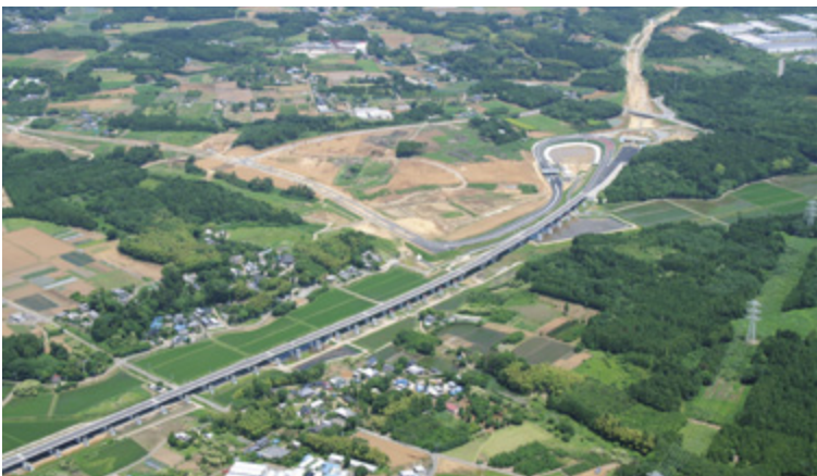
整備が進む圏央道(阿見東IC付近)
