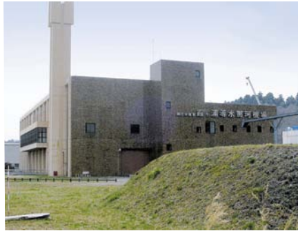
霞ヶ浦導水那珂機場
