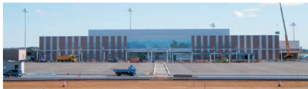
完成間近の茨城空港ターミナルビル
