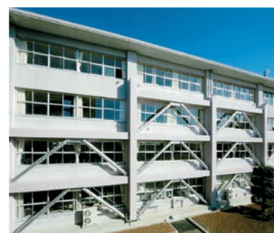
耐震補強工事を実施した県立高校
