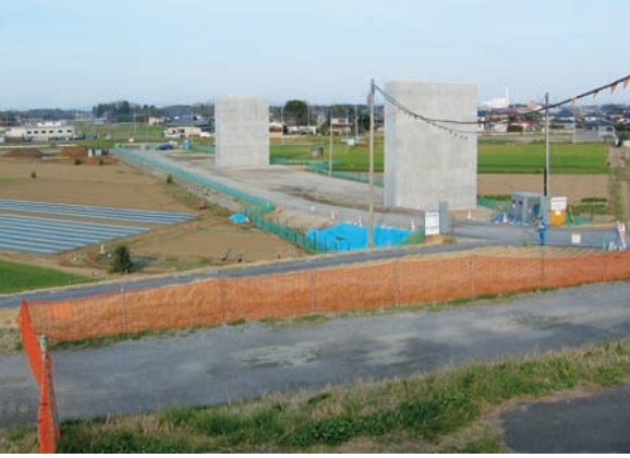
整備の進む圏央道
