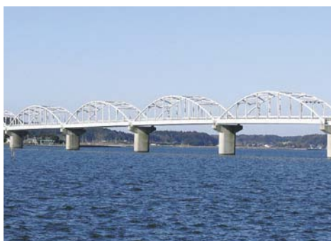
補修中の橋りょう (北浦大橋)
