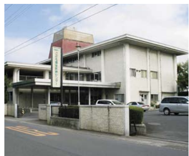
建て替え整備するこども福祉医療センター
