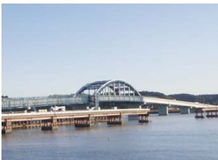
架け替え工事が進む鹿行大橋(写真奥)
