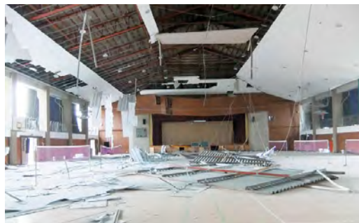
地震により天井が崩落した県立高校の体育館
