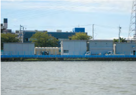
霞ヶ浦から見る直接浄化実証施設(土浦市)
