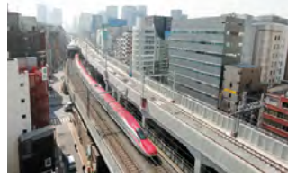
常磐線の東京駅乗り入れ工事の様子
