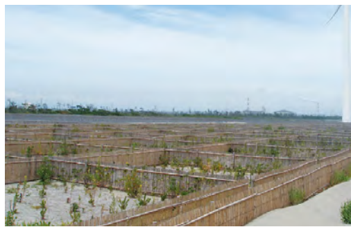
整備中の海岸防災林(神栖市)
