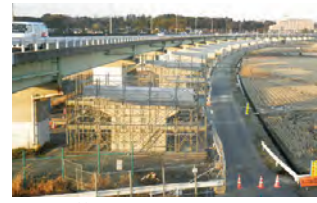
国道6号土浦バイパスの四車線化工事(土浦市)
