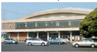
築50年が経過した東町運動公園体育館(水戸市)
