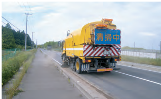
縁石周りの土砂・雑草の撤去
