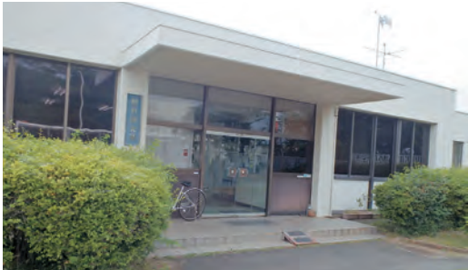
日本原子力研究開発機構大洗研究開発センター燃料研究棟 (大洗町成田町)
