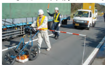
空洞探査機による調査の様子
