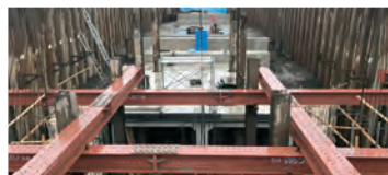
女沼川と中央排水路交差部の工事
