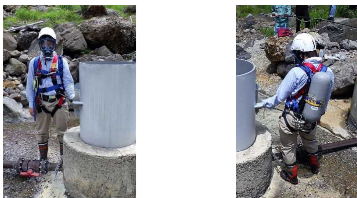
図 14 安全带と空気呼吸器を装備した作業員
