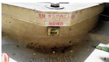
図 16 タンク開口部の施錠
