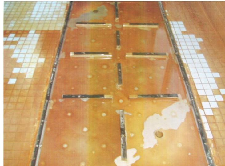
気泡板を外して、清掃できるようにした例
