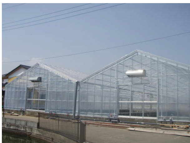
完成した昇温処理施設（全景）
