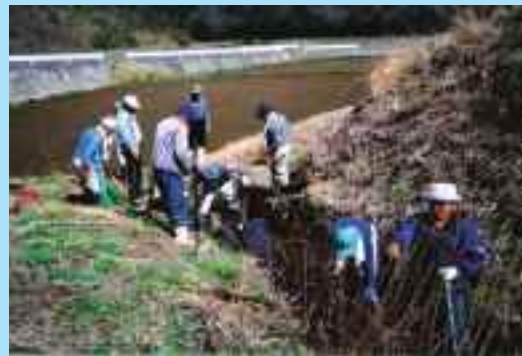
排水路の土砂払い
