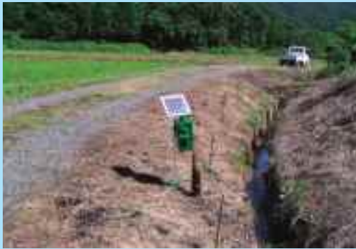
電気柵の設置
