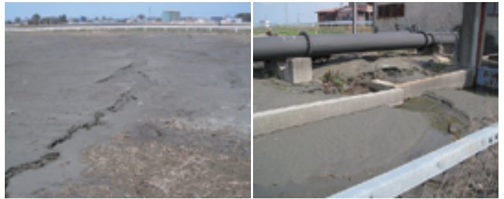
液状化と地割れした水田、農業揚水機場の損壊
