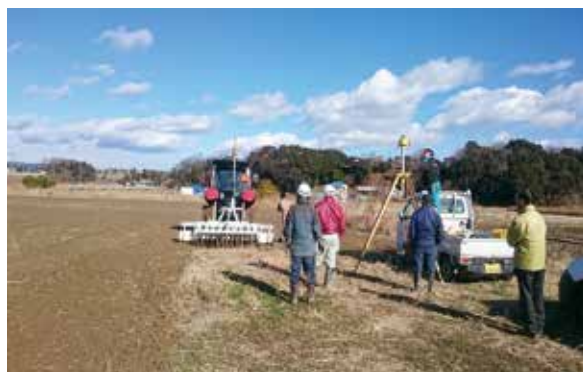
写真1 導入されたレーザーレベラーによる均平化作業
