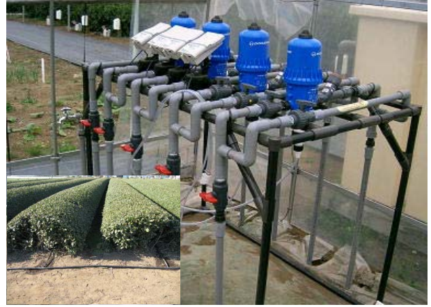
図 自動点滴施肥装置及び樹冠下点滴施肥の様子
