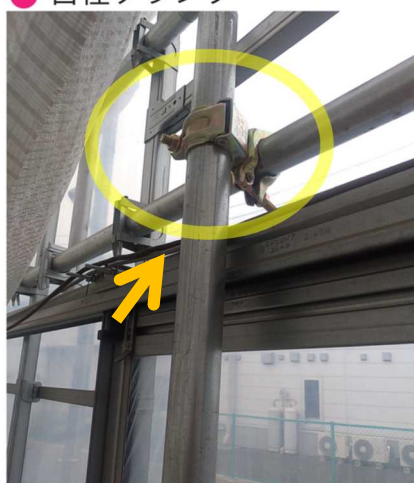
図-25 レール式ドアの補強パイプの取付 (レールが干渉しない場合は、クロス金具により固定)
