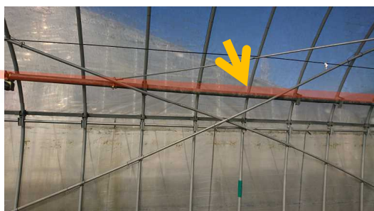
図- 29 足場用直管パイプによる側面補強
