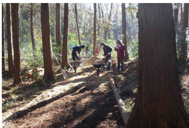
チップ敷き均し作業
