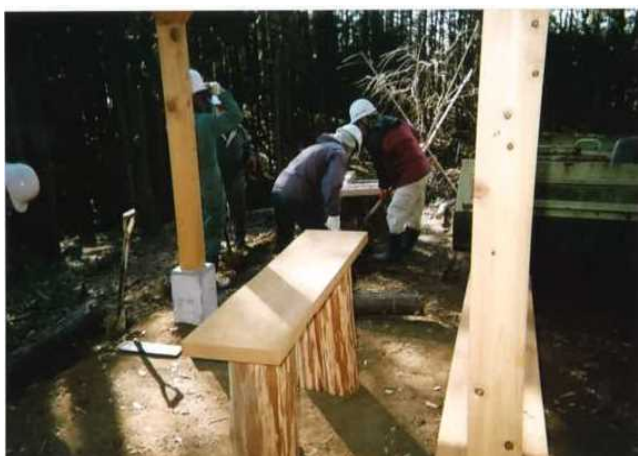
テーブル，ベンチの設置
