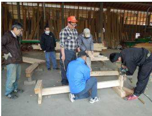
部材加工後は全体を調整しながら組み立て
