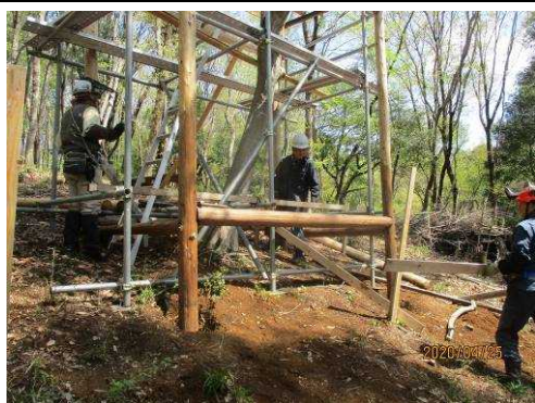
材料の搬入と組立作業
