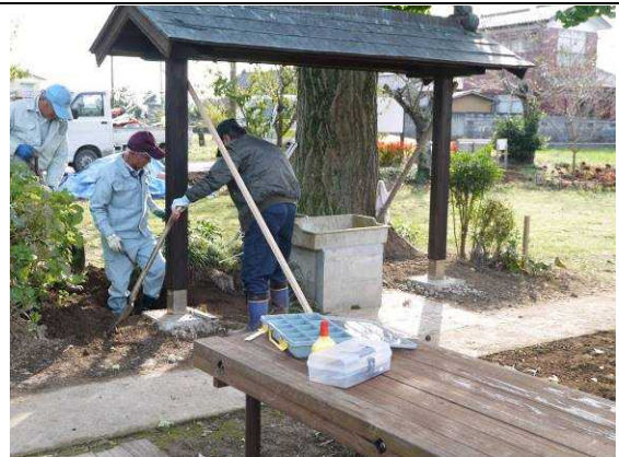
浸水した手水舎の復旧と補強作業
