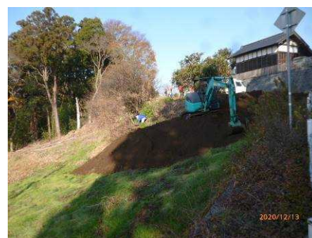
チップパーを下ろすため、道路づくり
