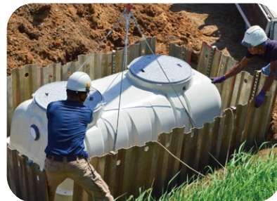
高度処理型浄化槽の設置を支援し、水質汚濁の原因となる窒素やりんを通常型の浄化槽より多く除去することができるようになりました。
