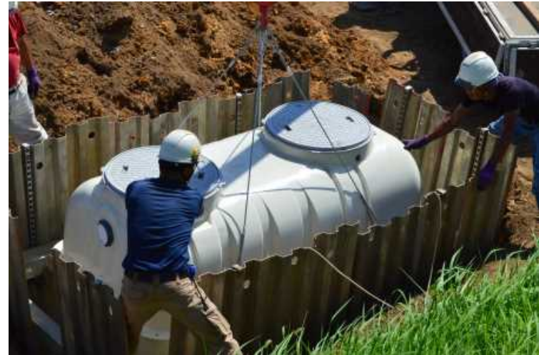
(高度処理型浄化槽の設置)
