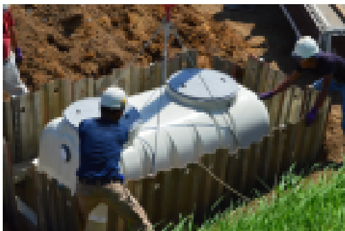
高度処理型浄化槽の設置
