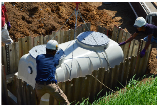
【高度処理型浄化槽の設置】
