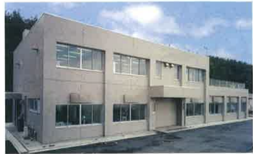
◎水産加工実験棟
